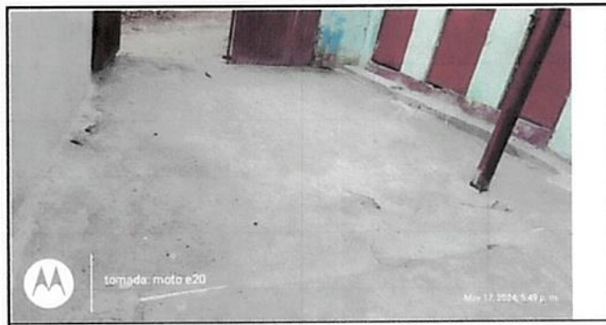
FUNDICION DE LOSA DE CONCRETO DE 0.08 CMS DE ESPESOR
