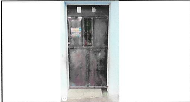
SUSTITUCION DE PUERTAS DE METAL
